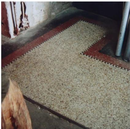
Abb. 30 Terrazzoboden am Durchgang zum Verwaltungsgebäude.
