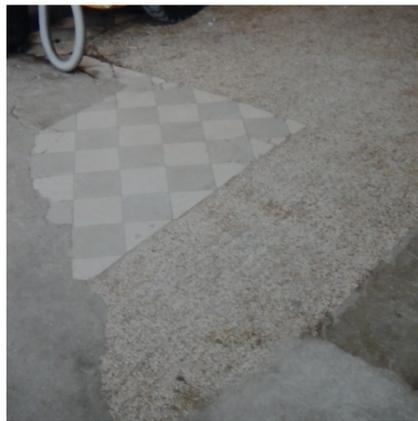
Abb. 31 Diagonal verlegte Fliesenfelder in der Maschinenhalle.
