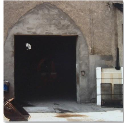
Abb. 38 Zugemauerter Spitzbogen des Zuganges Zum Kesselhaus.
