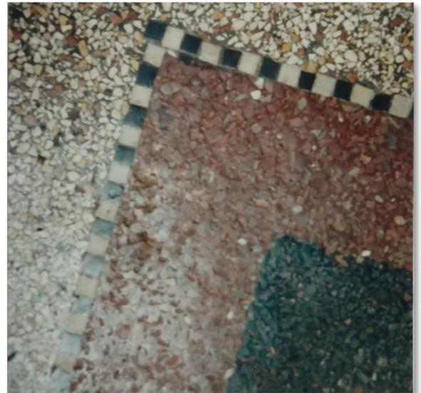
Abb.29 Terrazzoboden des Maschinenhauses.
