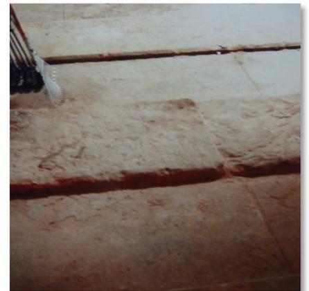
Abb. 32 Höhenversetzt verlegte Sandsteinplatten im Untergeschoß.
