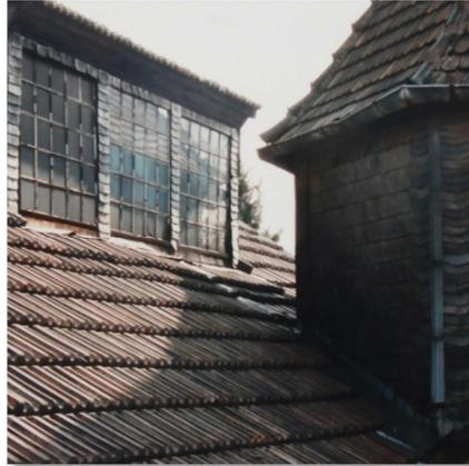
Abb. 40 Schleppgauben des Kesselhauses, rechts alter Wasserturm.
